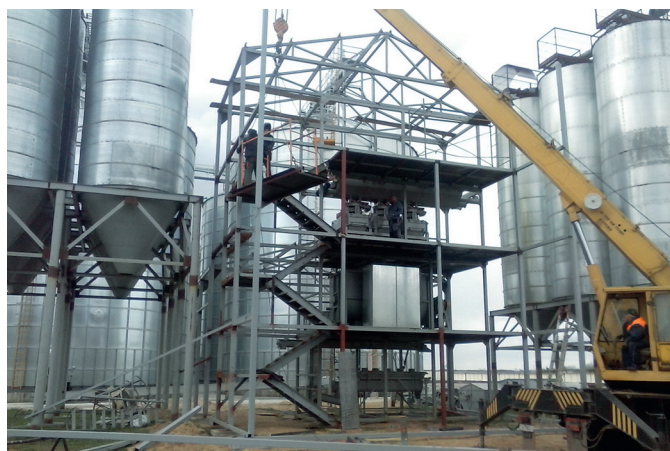
Рис. 2. Комплект комбикормового оборудования в процессе монтажа
