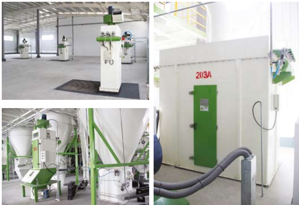
Фото 2—4. Оборудование для улавливания пыли
