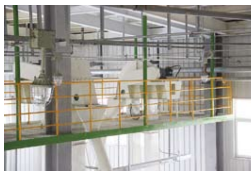
Фото 5–7. Результат принятых мер по устранению пыли (совершенствование технологического процесса, герметизация, своевременная уборка)
