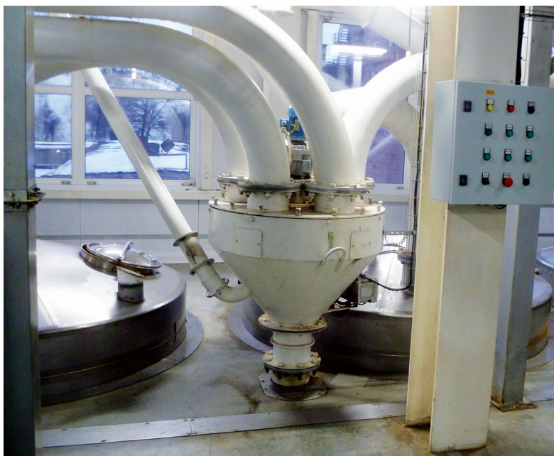
Рис. 3. Переключатель потоков КПП-5-200 с пультом управления (на столбе)
