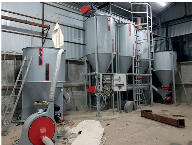
В процессе монтажа
