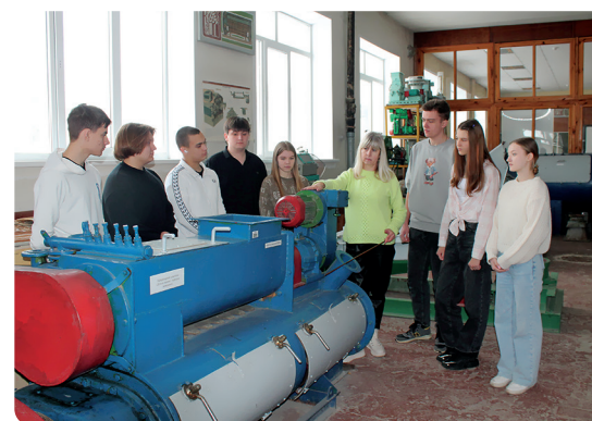
Знакомство с оборудованием машинного зала колледжа
