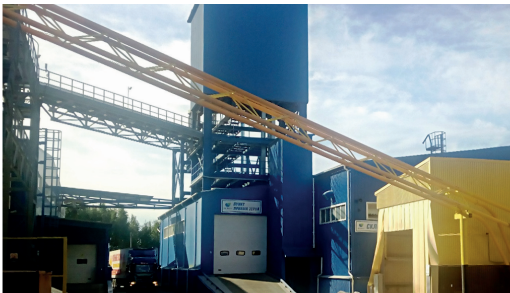
Участок приема сырья, оборудованный пневмотранспортом
