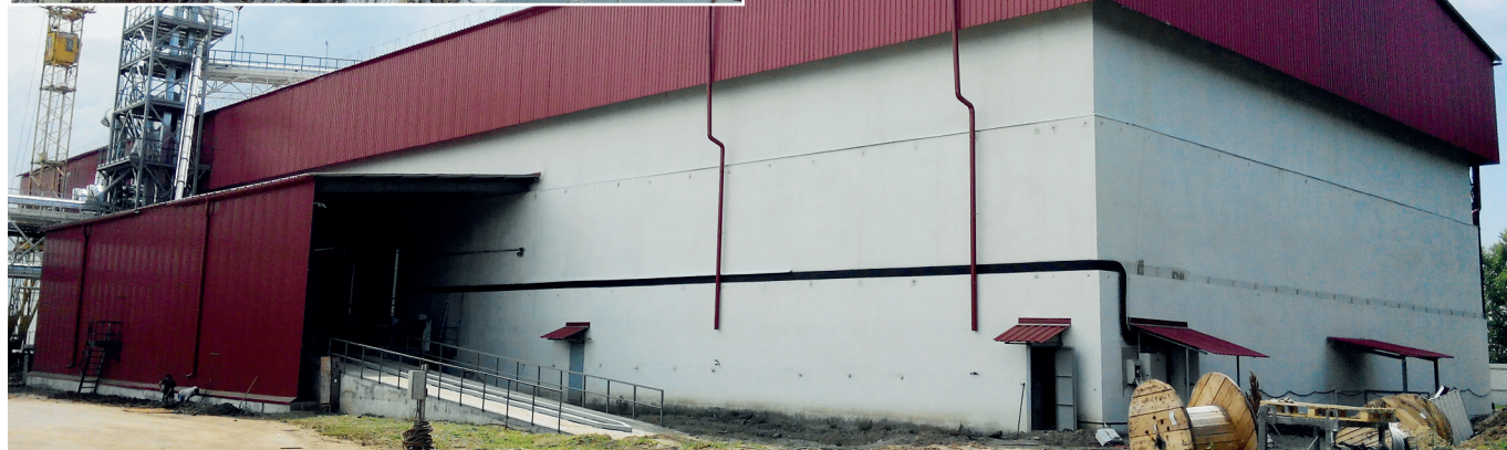
Силосный корпус и зерносклад из железобетона (ООО «Волгохлебстроймонтаж»)
