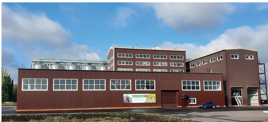
Рис. 8. Блочно-модульный комбикормовый завод производительностью 20 т / ч
