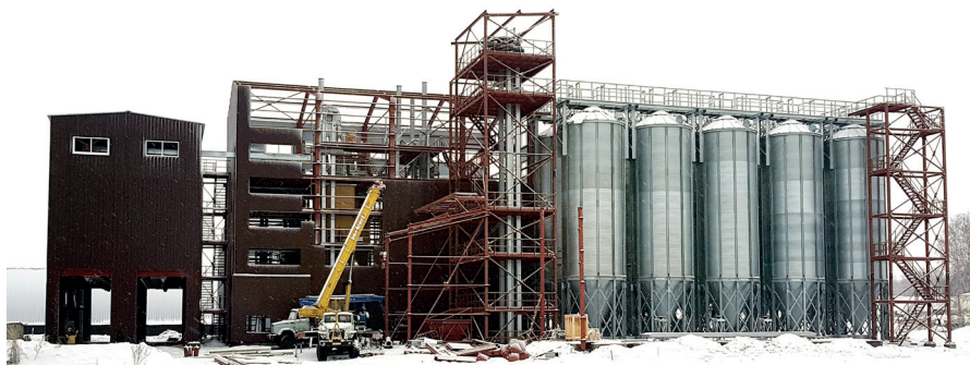
Рис. 7. Сборка блочно-модульного комбикормового завода производительностью 20 т/ч
