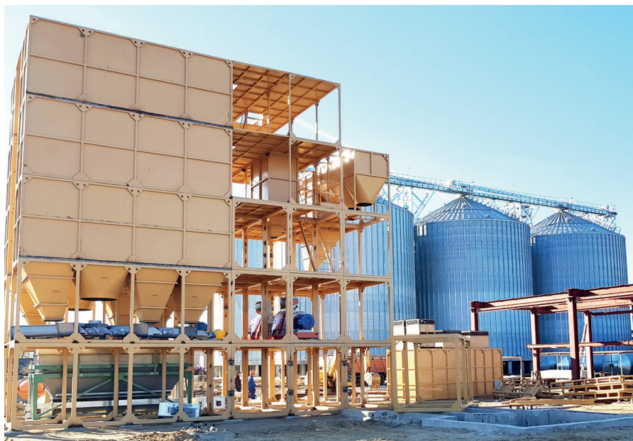
Рис. 6. Контрольная сборка всех блоков по модулям с установкой основного технологического оборудования
