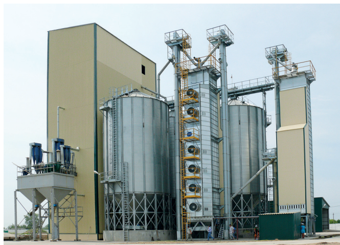
Привязка силосов с коническим дном к зерносушилке
