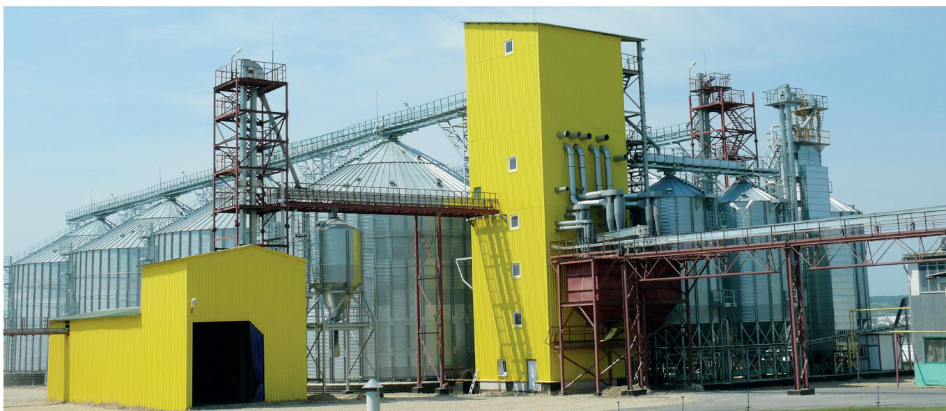
Зернохранилище с металлическими силосами (ОАО «Мельинвест»)
