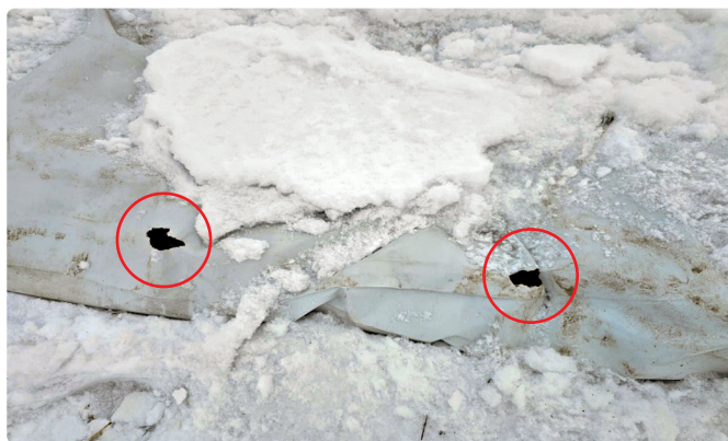
Рис. 2. Места повреждений в конструкции силобега, 2024 г.
