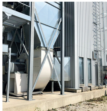
Рис. 9. Система очистки отработанного воздуха
