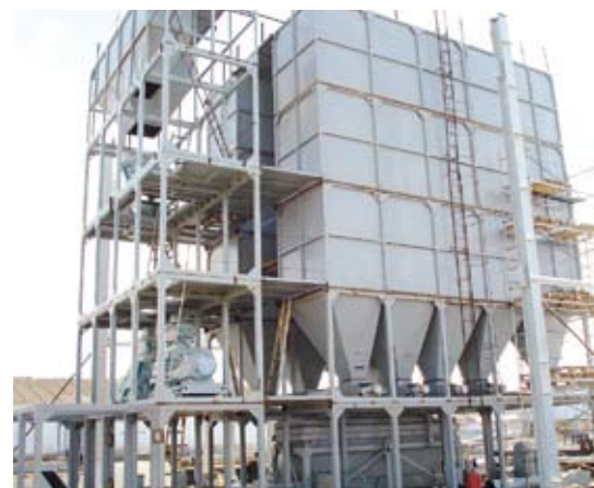
Рис. 3. Сборка модулей на строительной площадке
