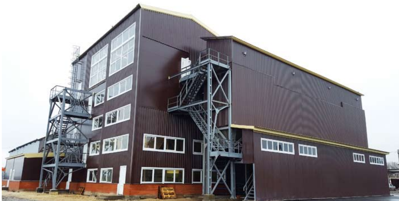
Рис. 4. Комбикормовый завод производительностью 10 т/ч в блочно-модульном исполнении
