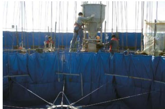
ральных удобрений. Работы выполнялись в круглосуточном режиме, поэтапно. Каждый силос заливался бетоном отдельно в течение 7–8 дней, столько же дней уходило на демонтаж/монтаж опалубки. Сроки строительства силосной части составили 2,5 месяца, причем в зимнее время. Стоимость тонны хранения в пересчете на зерно — около 6,8 тыс. руб.
