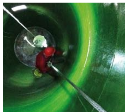
Нанесение полиуретанового антиадгезионного износостойкого покрытия
